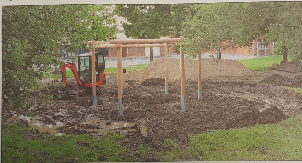
Gerüst für den Neuzugang: Auf dem Schulhof der Grundschule Grüner Weg wird eine sogenannte Sechseckrundell-Schaukel aufgestellt, ermöglicht durch eine Spende des Fördervereins.
